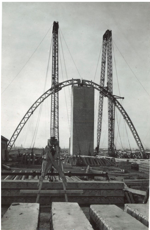
4.kép Az első ívpár emelése. Eldőlés ellen a már elkészült lépcsőház-torony biztosít No. 854
