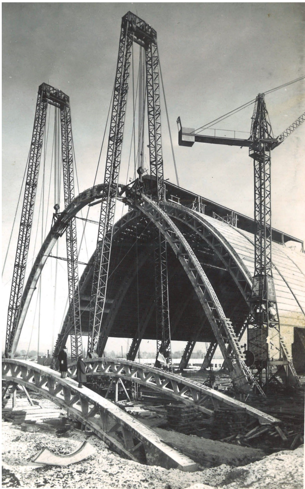
7.kép A csarnok belső képe építés alatt. A fedés 9,0 m hosszú kispaneljeit az állékonyság biztosítása érdekében és persze a felszabaduló területet kihasználva folyamatosan elhelyezték. No. 942
