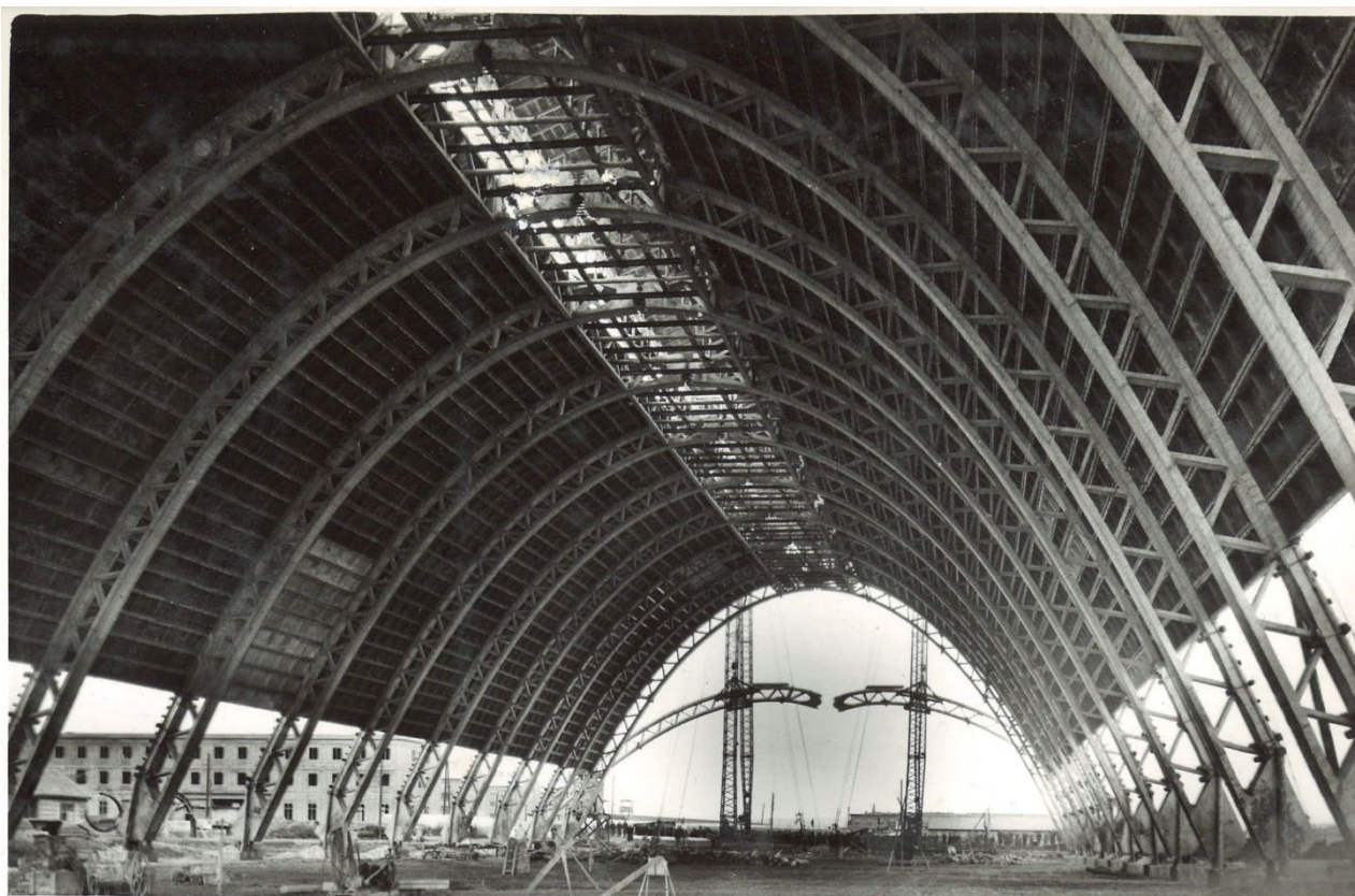
8.kép Külső kép építés alatt. A kisebb daru a „kiselemek” elhelyezését szolgálja No. 930
